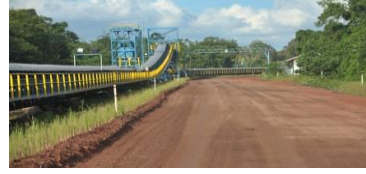
Conveyor menuju jetty
