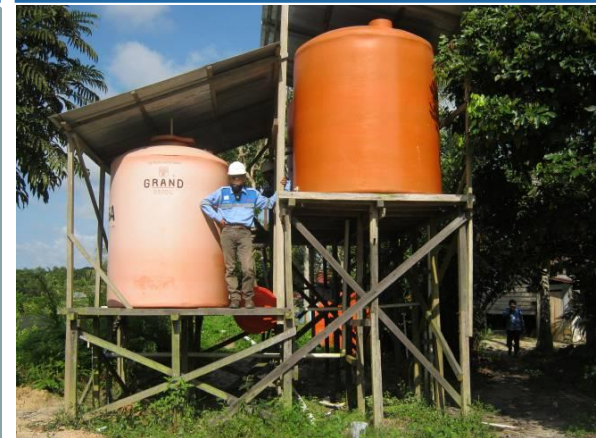
Penyediaan Instalasi Air Bersih
