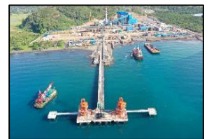
MCL Jetty Construction
